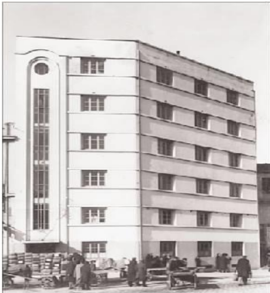
Η καπναποθήκη Γαβριηλογλου στην οδό Δωδεκανήσου. Κτιστηκε το 1937 και σήμερα στεγάζει άλλες χρήσεις (φωτ.: αρχείο οικογένειας Γαβριηλογλου).
